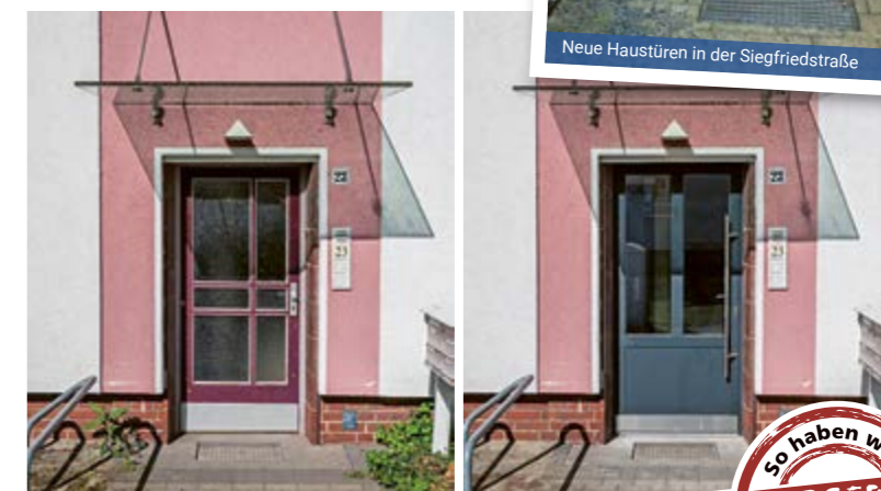
Die Haustür der Isoldestraße 23 vor und nach dem Einbau
