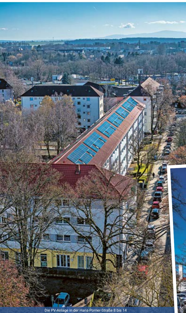
Die PV-Anlage in der Hans-Porner-Straße 8 bis 14
