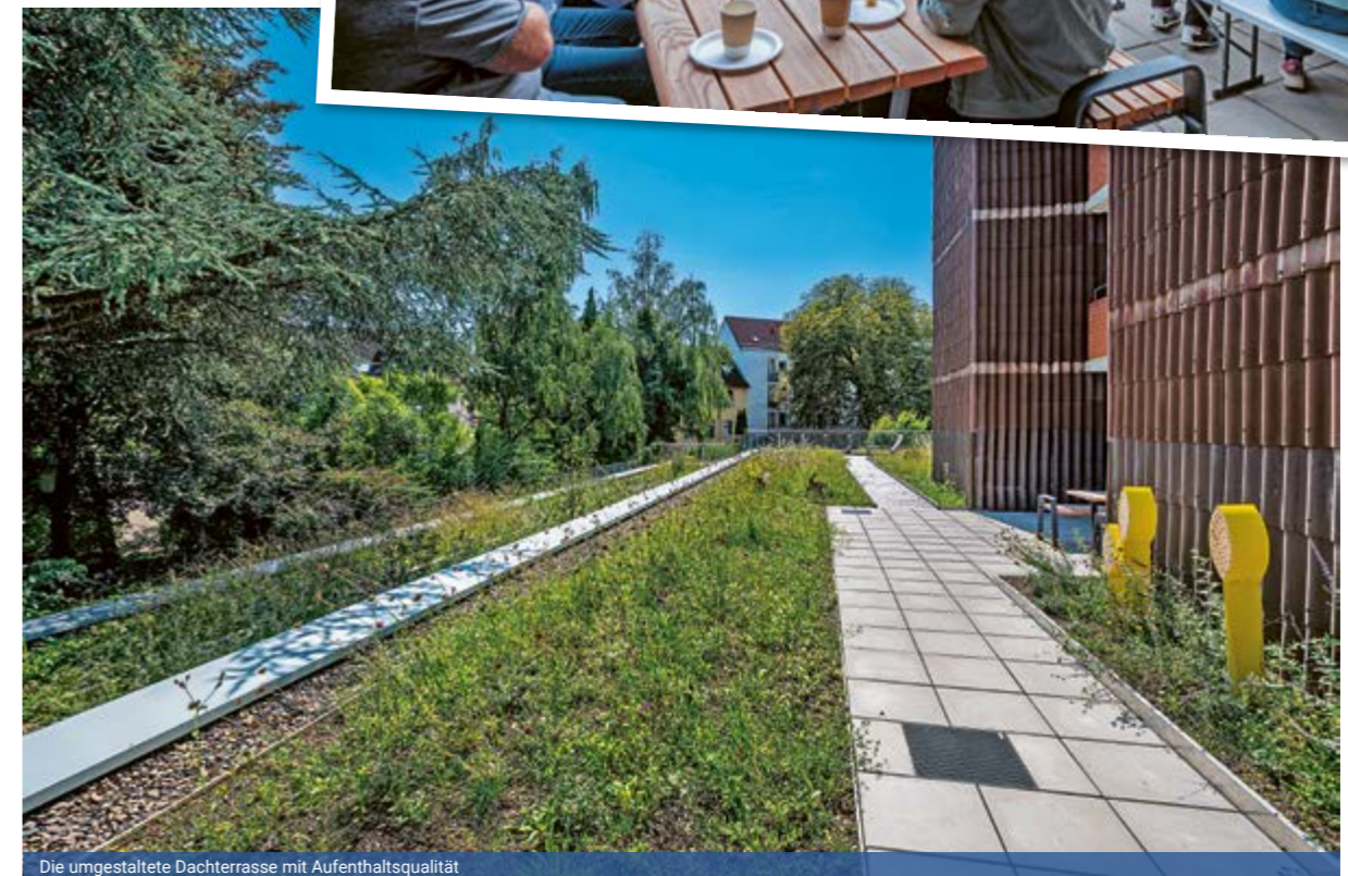
Die umgestaltete Dachterrasse mit Aufenthaltsqualität
