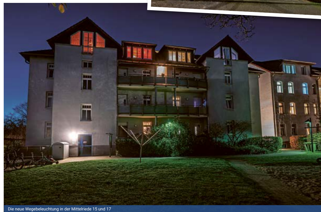
Die neue Wegebeleuchtung in der Mittelriede 15 und 17
